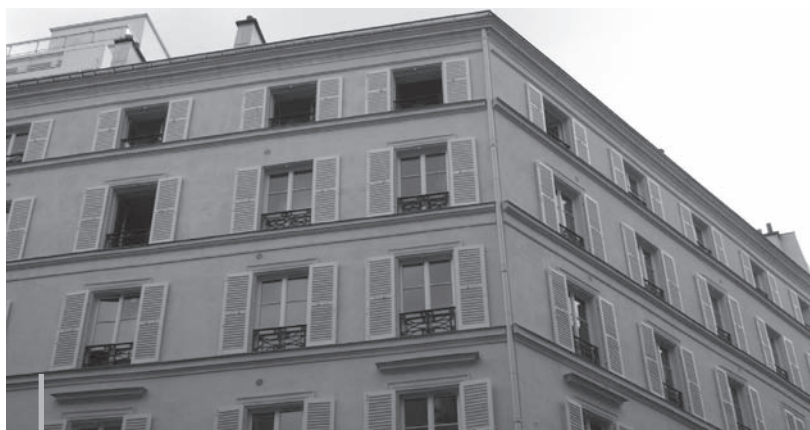
Façades sur Rues Ponthieu - Colisée - après rénovation
