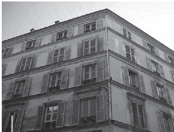
Façades sur Rues Ponthieu - Colisée - avant rénovation
